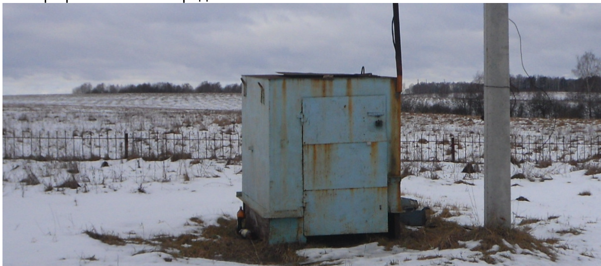
Рис. 1.5. Павильон с электрическим щитом и прибором учета электроэнергии артезианской скважины 1 с. Кузьмищево
