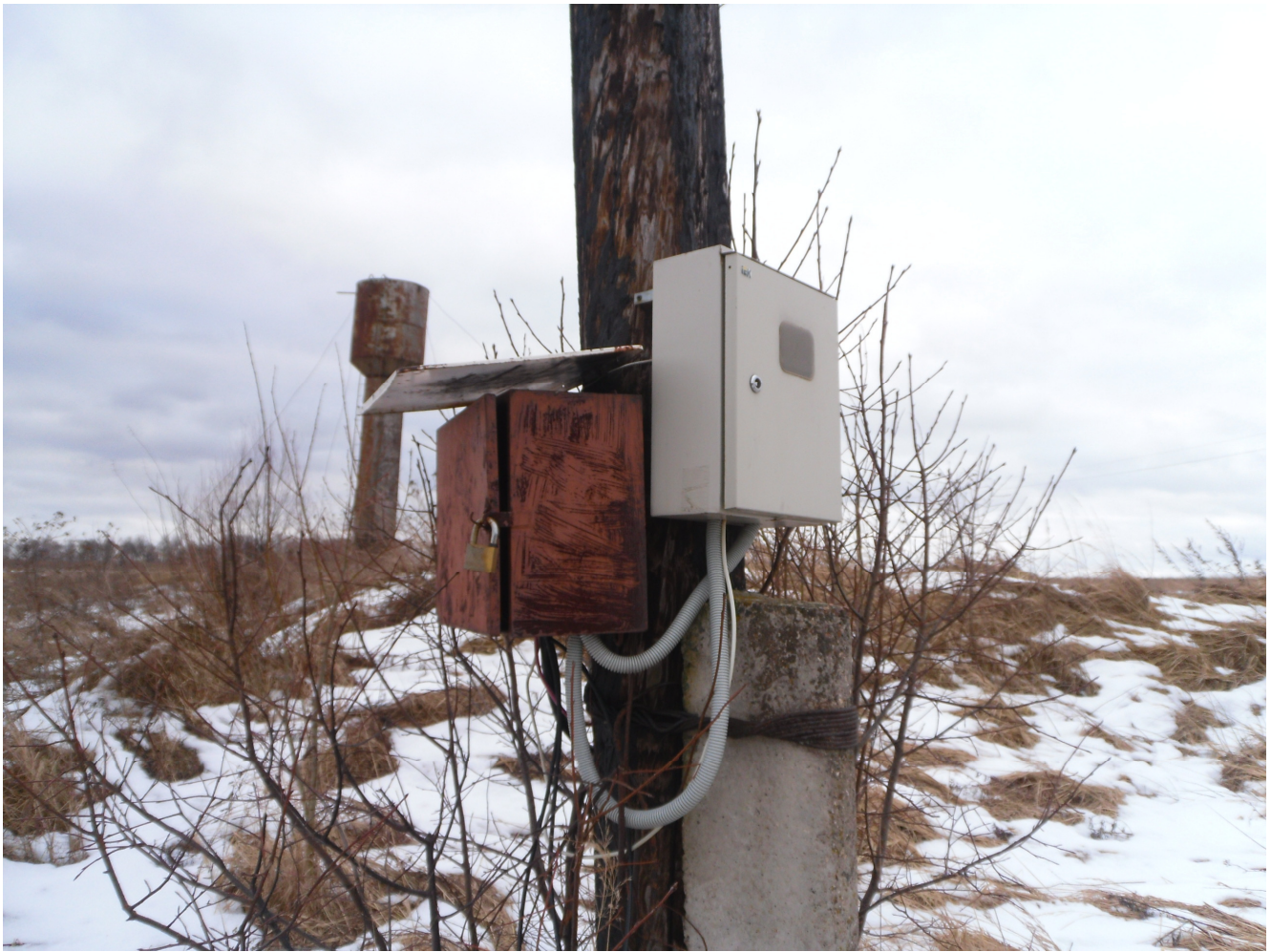
Рис. 1.9. Электрический щит и прибором учета электроэнергии артезианской скважины д. Большуново
