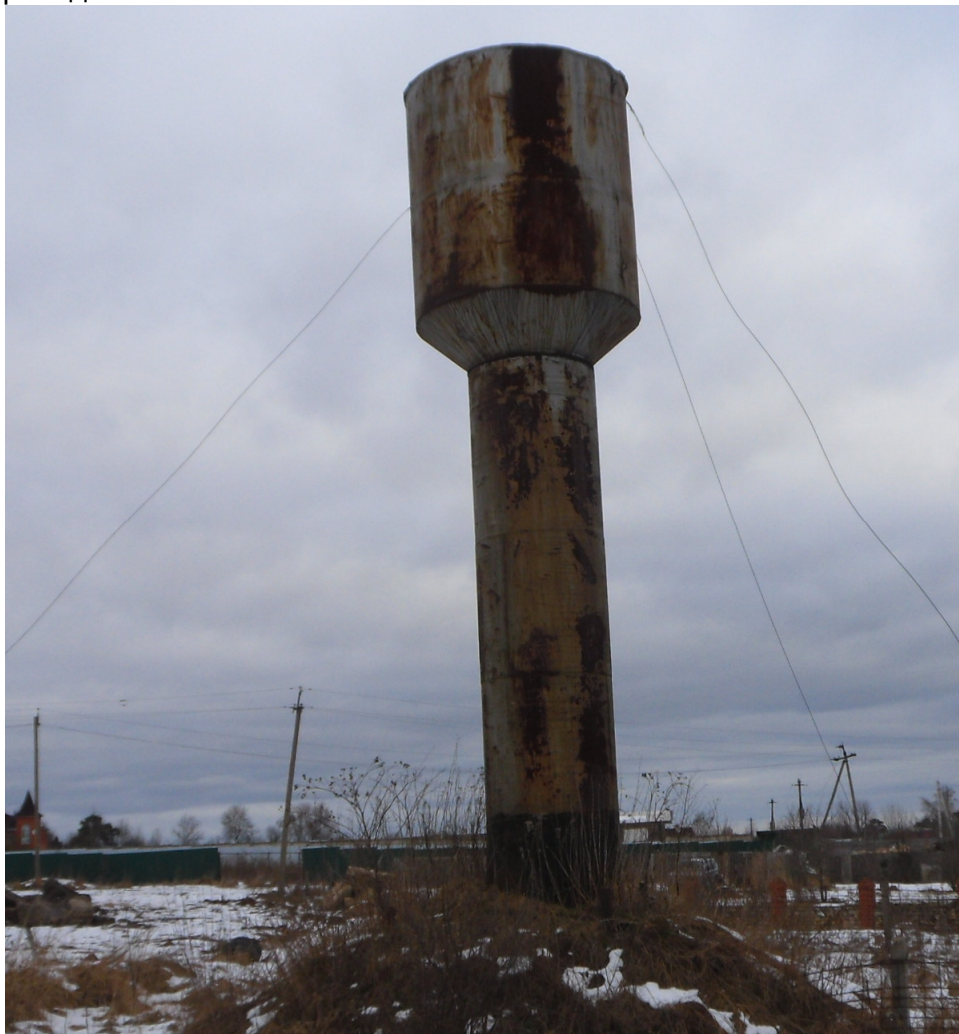
Рис. 1.14. Водонапорная башня д. Строитель
