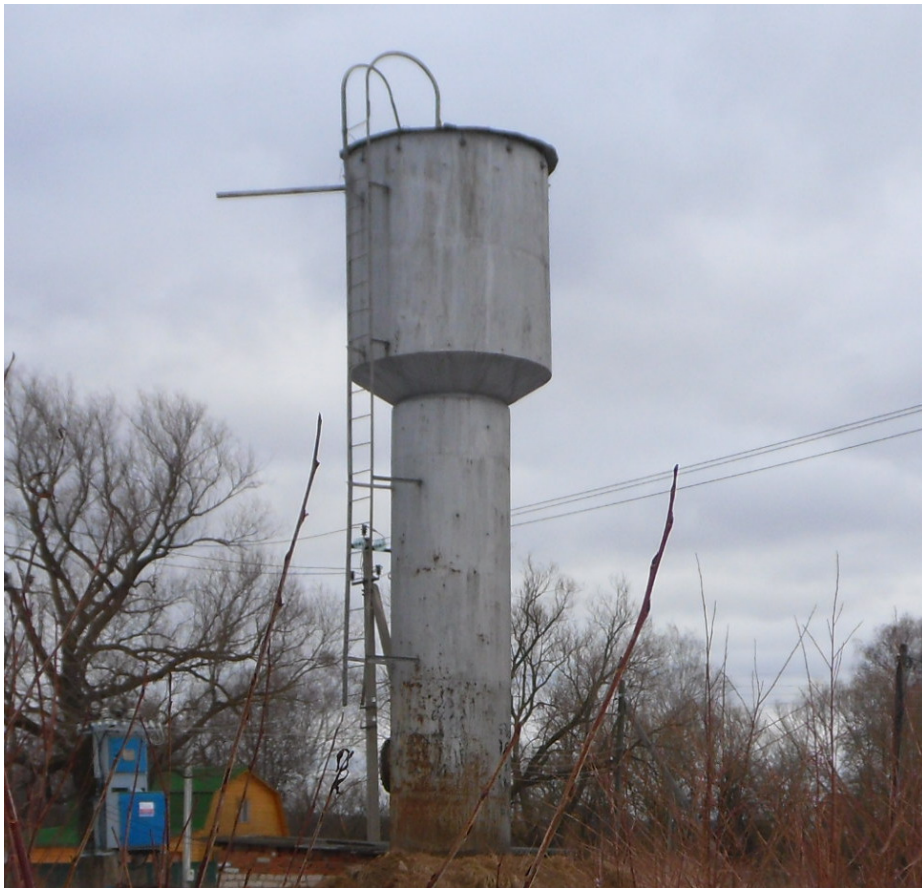
Рис. 1.8. Водонапорная башня от артезианской скважины 2 с. Кузьмищево
