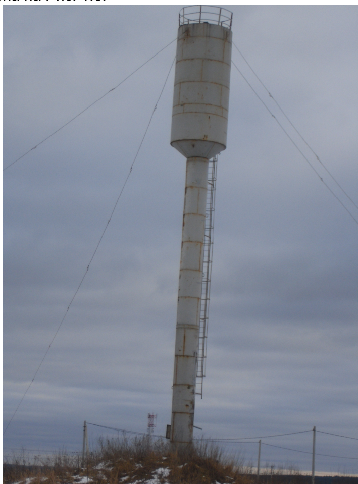
Рис. 1.6. Водонапорная башня от артезианской скважины 1 с. Кузьмищево
