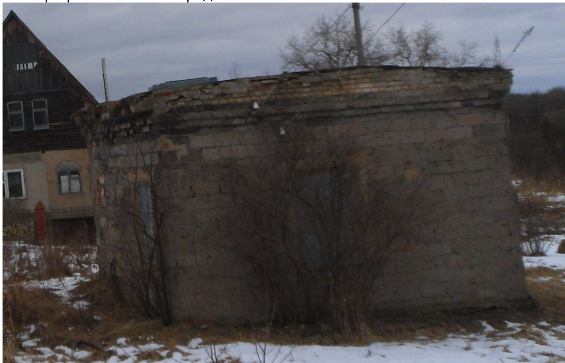
Рис. 1.13. Павильон с электрическим щитом и прибором учета электроэнергии артезианской скважины д. Строитель
