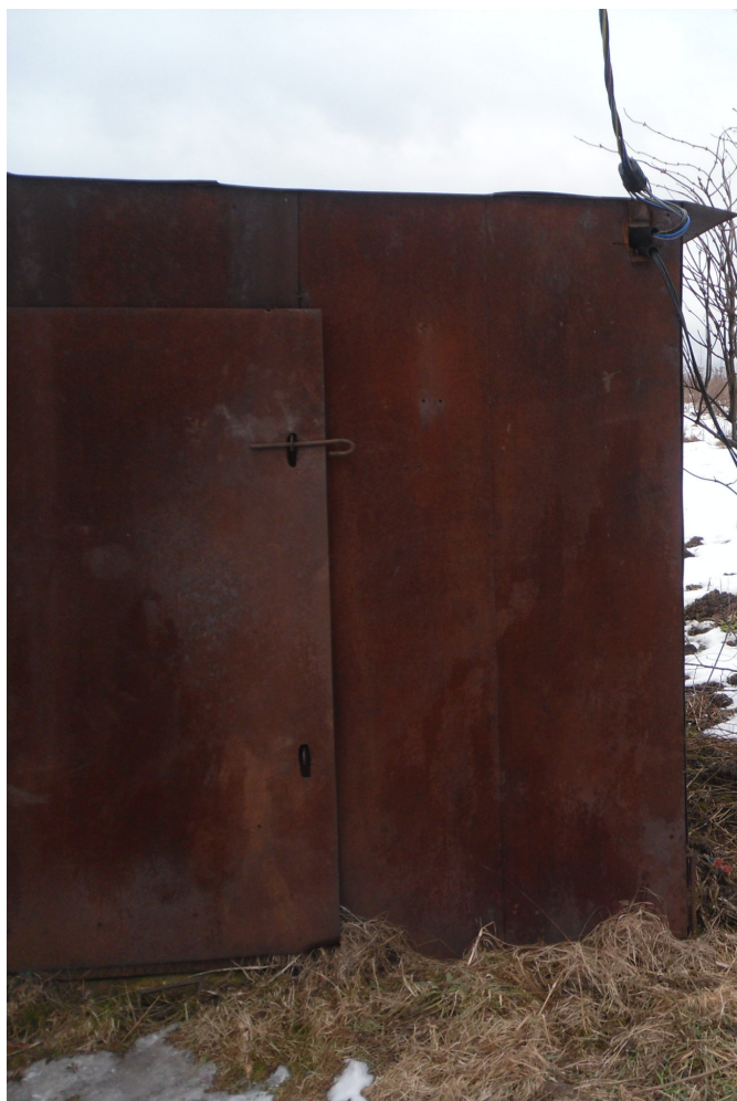
Рис. 1.11. Павильон с электрическим щитом и прибором учета электроэнергии артезианской скважины д. Бояково
