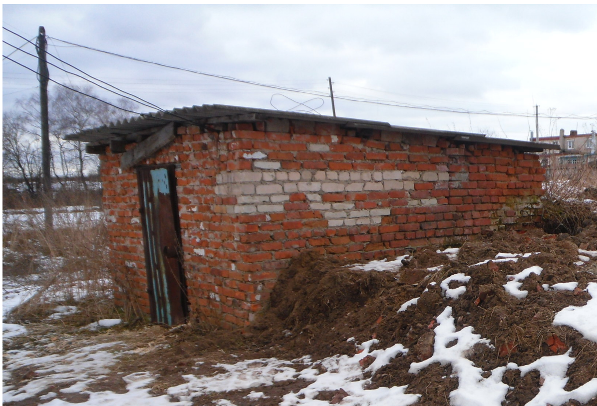
Рис. 1.7. Павильон с электрическим щитом и прибором учета электроэнергии артезианской скважины 2 с. Кузьмищево
