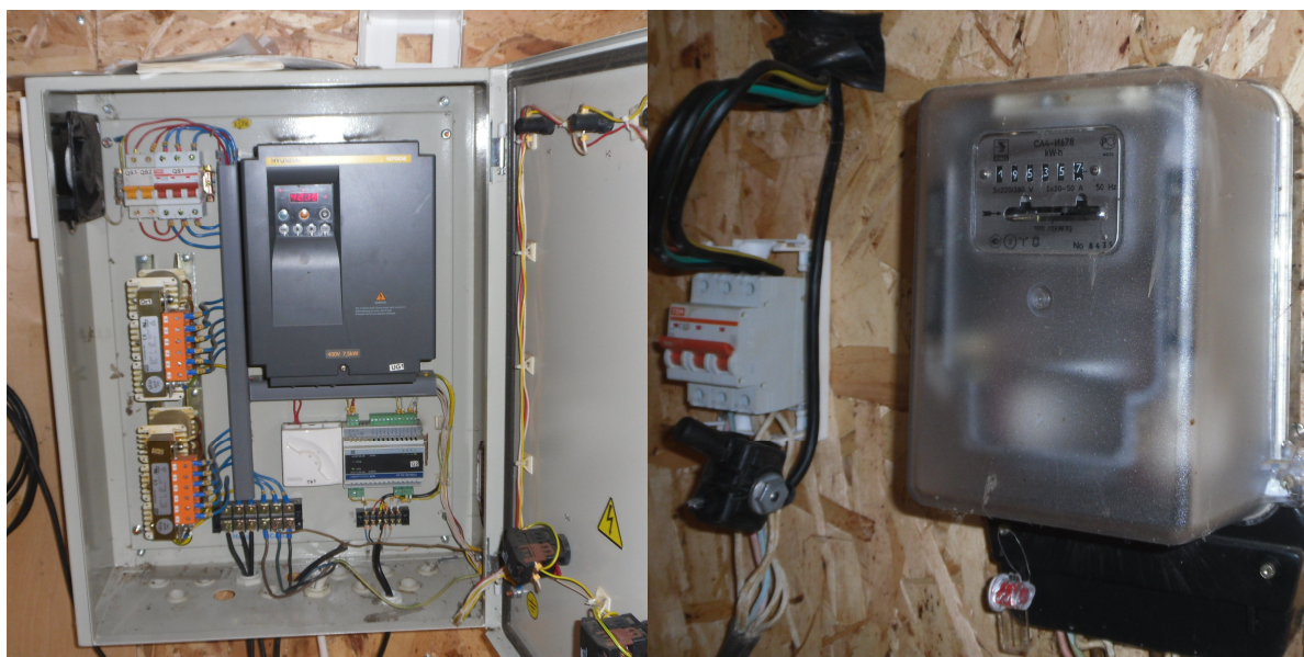
Рис. 1.12. Электрический щит и прибор учета электроэнергии артезианской скважины д. Бояково
