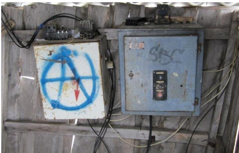
Рис. 1.3. Электрический щит и шкаф прибора учета электроэнергии
