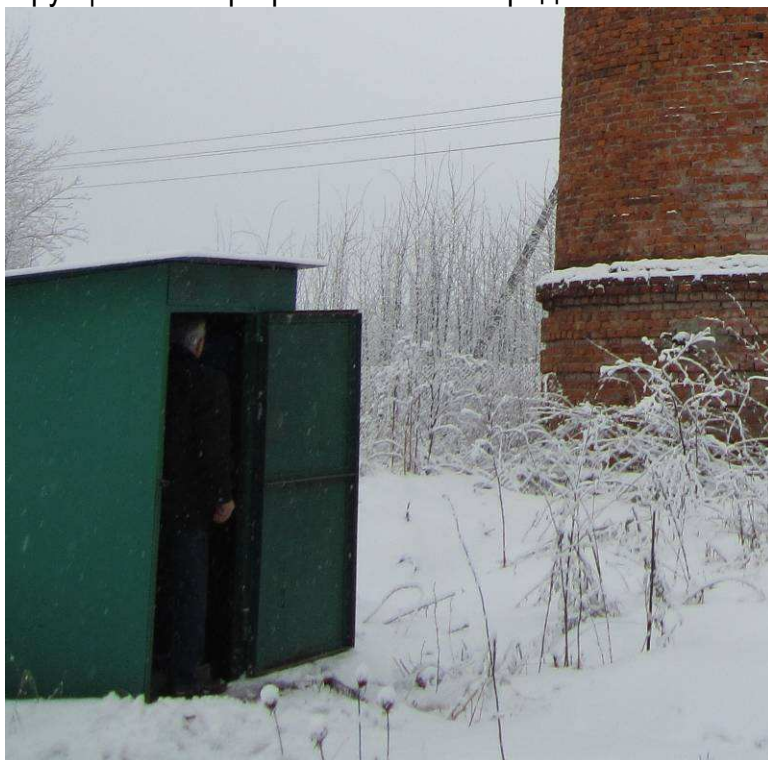
Рис. 1.2. Павильон с электрическим щитом и прибором учета электроэнергии с. Вознесенье
