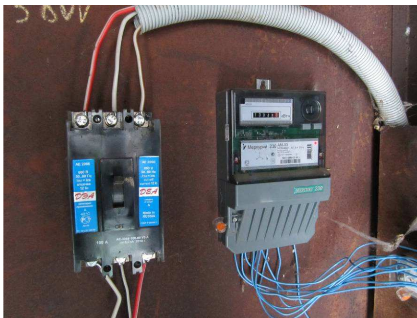
Рис. 1.3. Электрический щит и шкаф прибора учета электроэнергии
