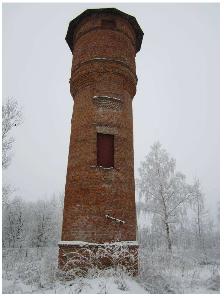
Рис. 1.4. Водонапорная башня с. Вознесенье
