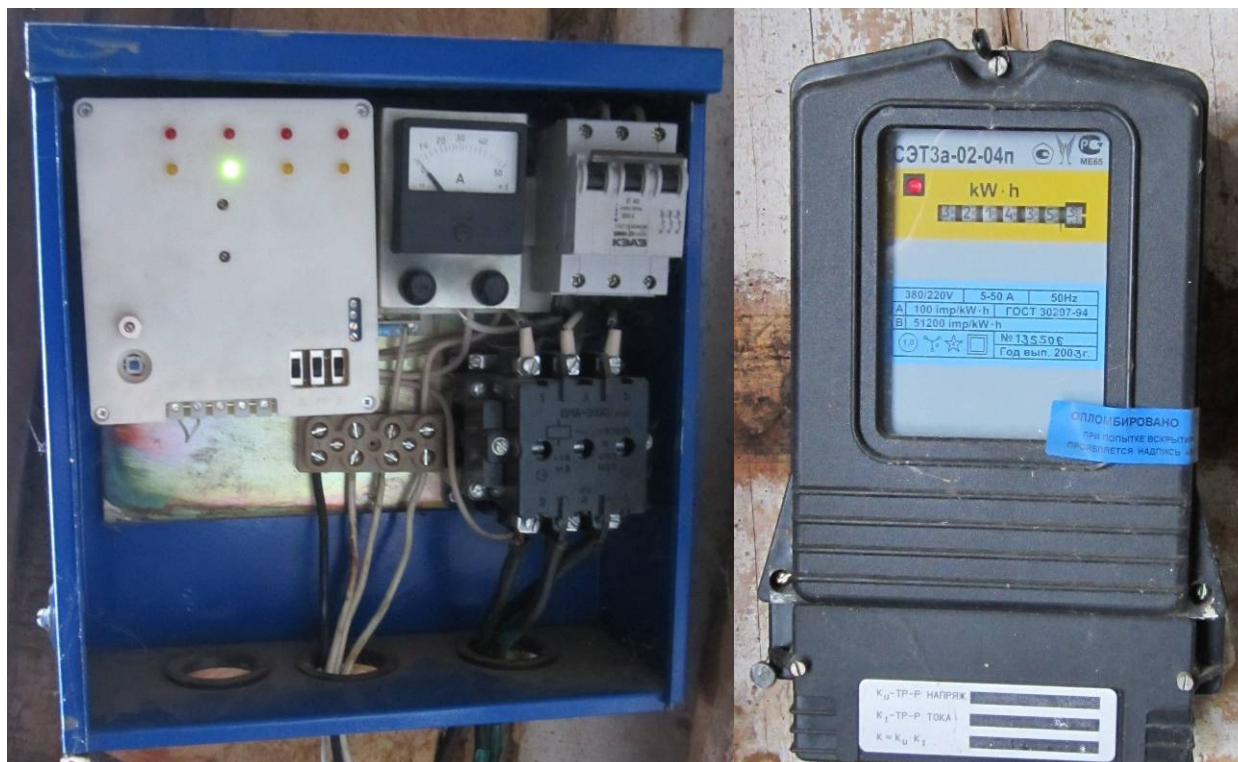
Рис. 1.5. Электрический щит и прибор учета электроэнергии
