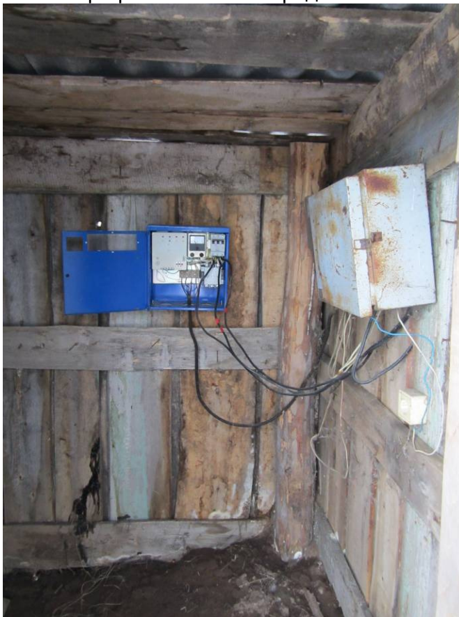
Рис. 1.8. Павильон с электрическим щитом и прибором учета электроэнергии д. Истомино
