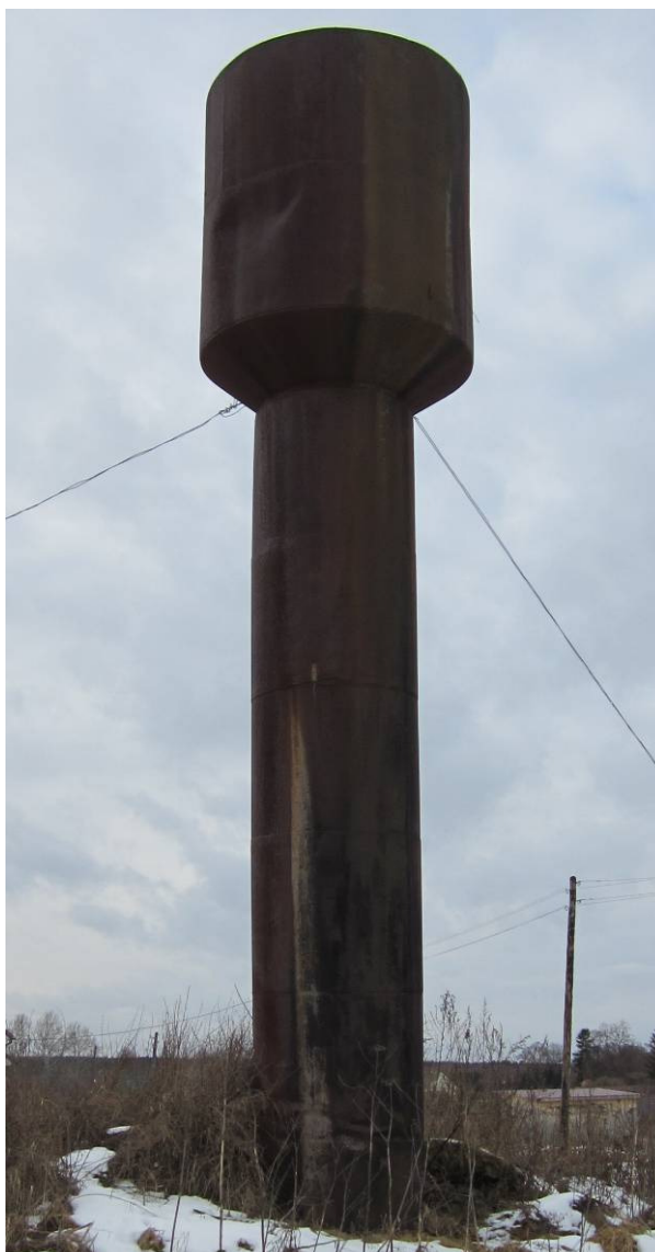
Рис. 1.10. Водонапорная башня д. Истомино
