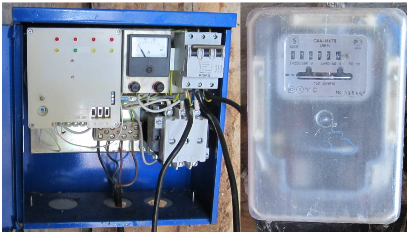
Рис. 1.9. Электрический щит и шкаф прибора учета электроэнергии
