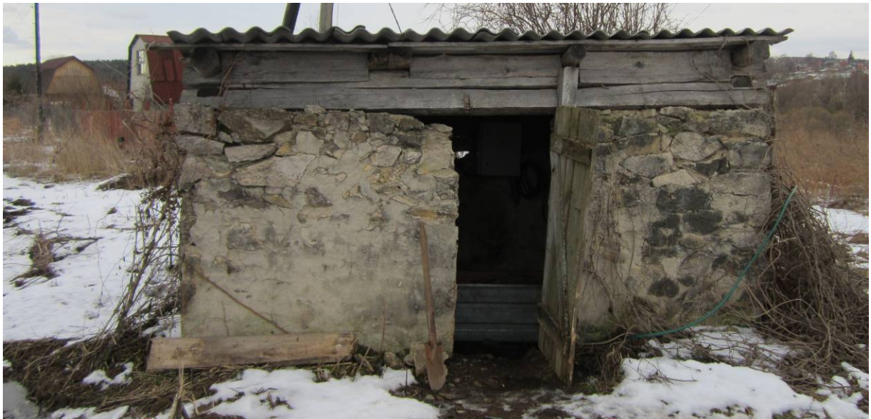
Рис. 1.11. Павильон с электрическим щитом и прибором учета электроэнергии д. Слободка
