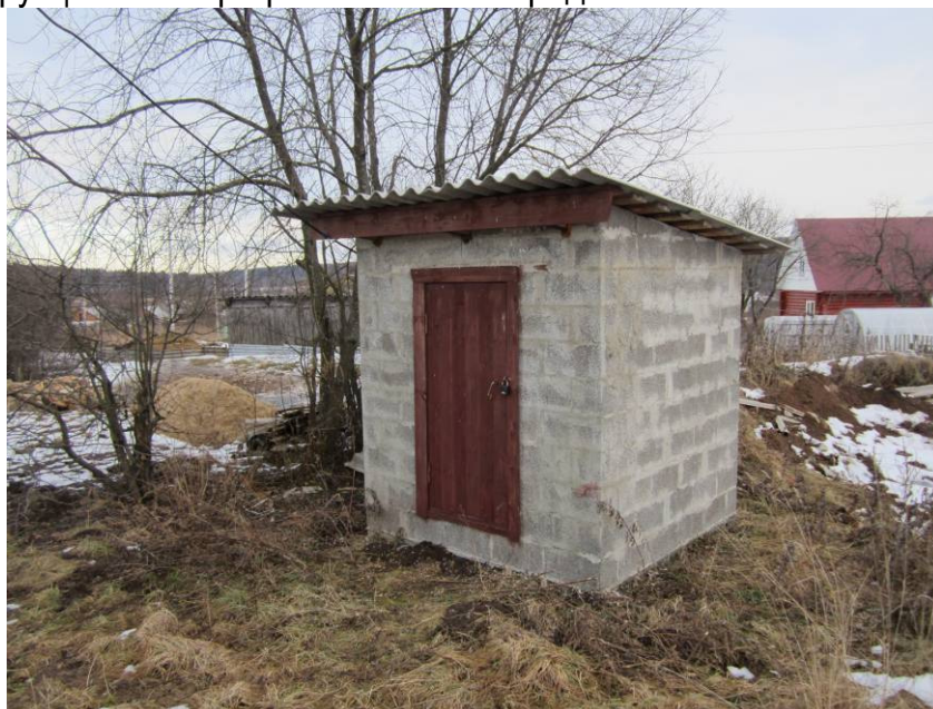
Рис. 1.7. Павильон насосной станции д. Похвиснево
