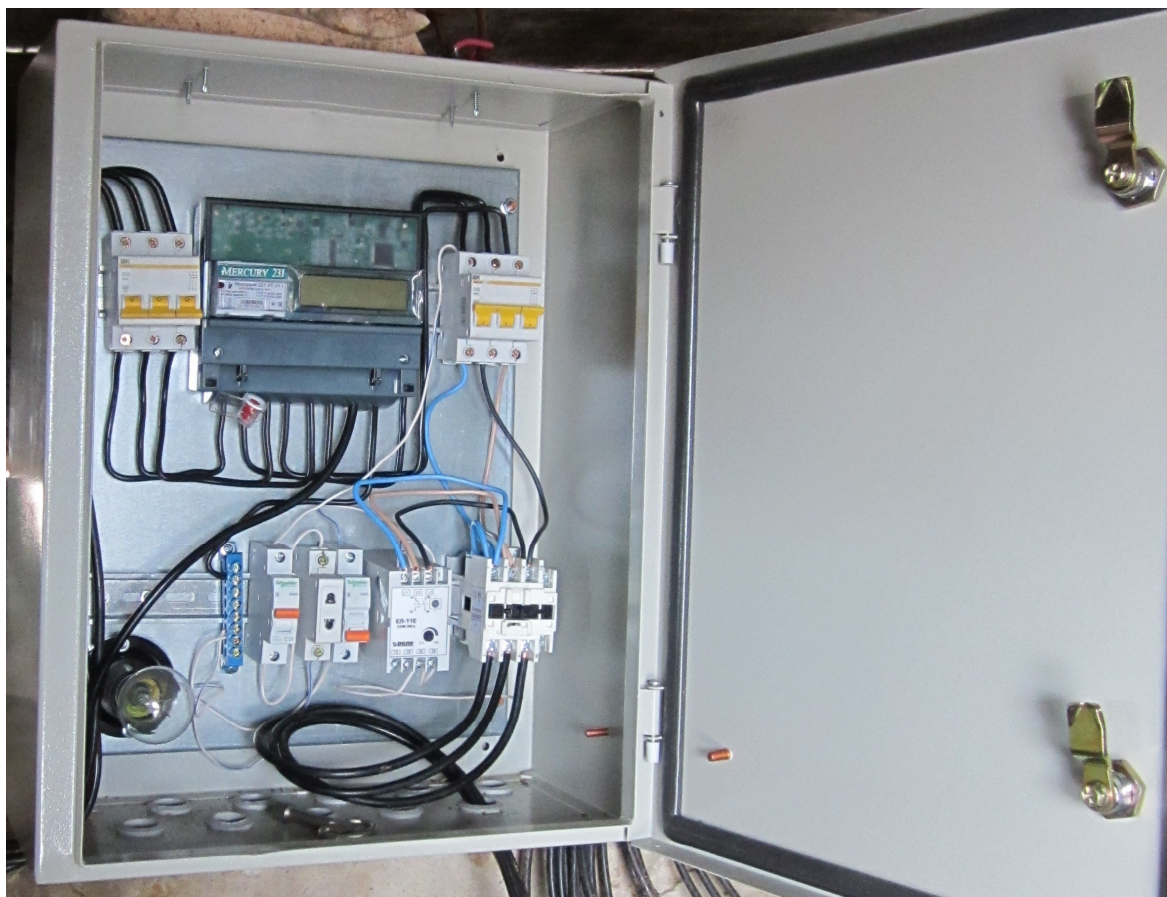
Рис. 1.12. Электрический щит и прибор учета электроэнергии
